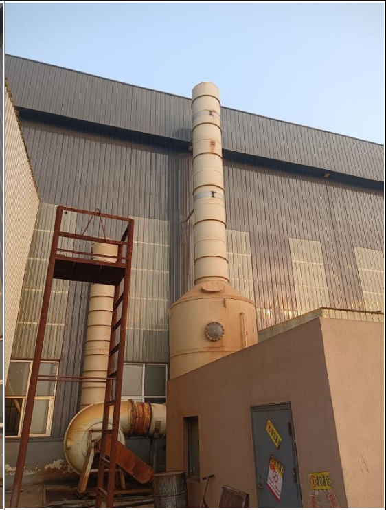
#1 车间酸雾吸收塔+15m 高排气筒
