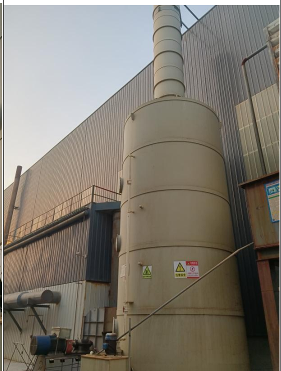
喷砂机+布袋除尘器+15m 高排气筒
