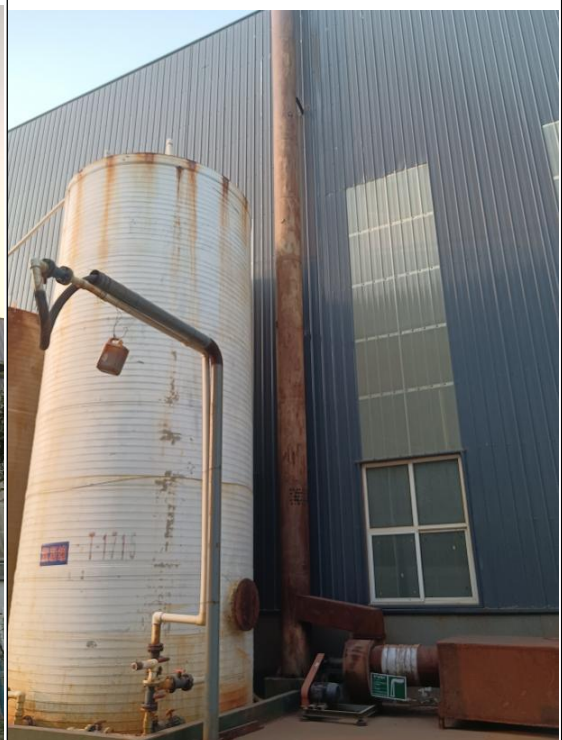
#1 车间酸雾吸收塔+15m 高排气筒
