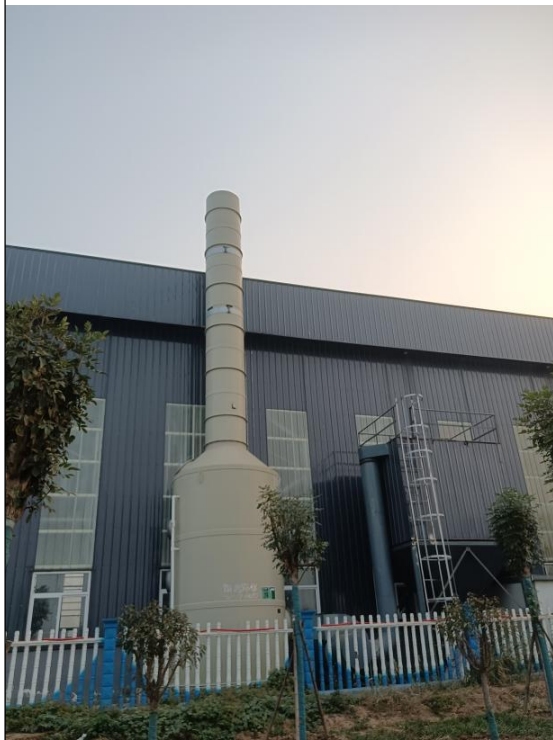
#1 车间酸雾吸收塔+15m 高排气筒
