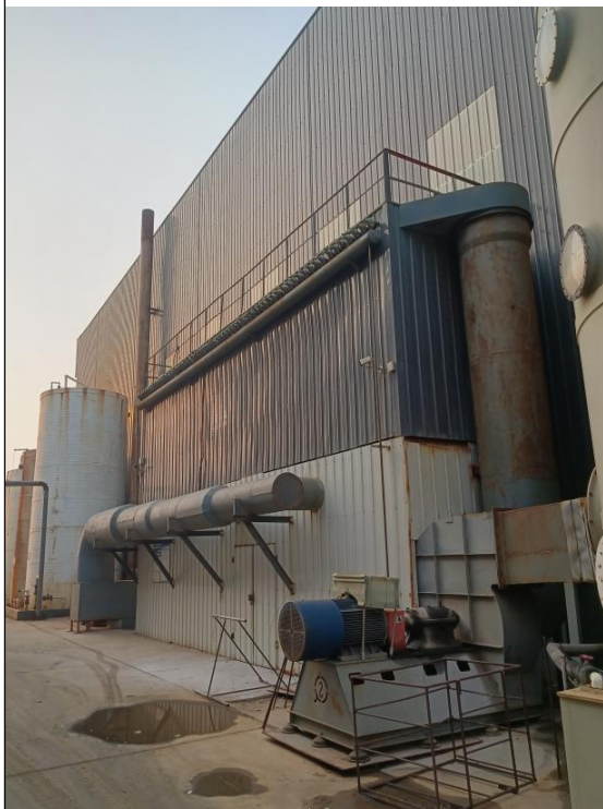
喷砂机+布袋除尘器+15m 高排气筒
